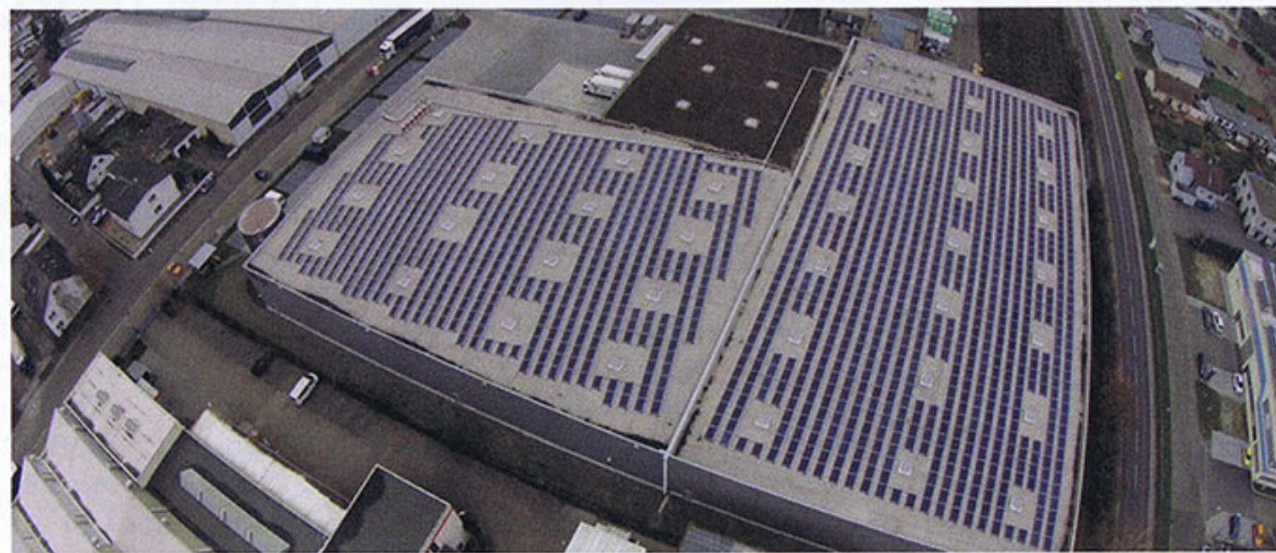
Das Logistikzentrum der Erdt-Gruppe in Viernheim wurde 2013 in Betrieb genommen. Der durch die Solarzellen auf dem Dach erzeugte Strom wird zu 37 Prozent selbst genutzt
